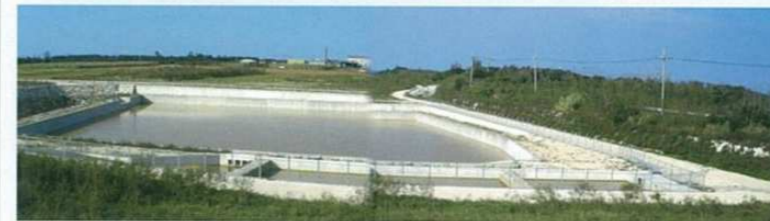
県営畑地帯総合整備事業(担い手支援型) 寄草地区 貯水池
