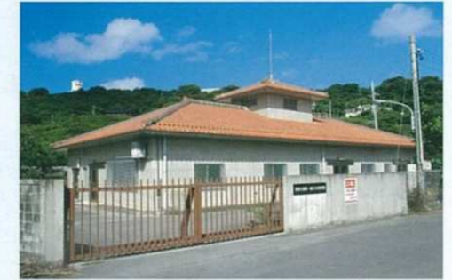
農業集落排水事業(玉城第一地区)南城市
