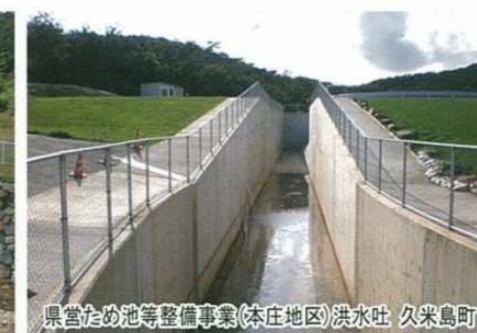
県営ため池等整備事業(本庄地区)久米島町
