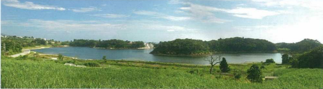
県営かんがい排水事業(カンジン地区 平成17年)
